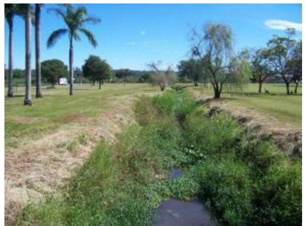
Foto 4.40 - Aspectos da sub-bacia M-D-17. (Fonte: Plano de Drenagem, 2011)
