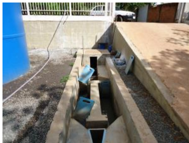
Foto 4.24 – ETE Alvorada – unidade de entrada.
