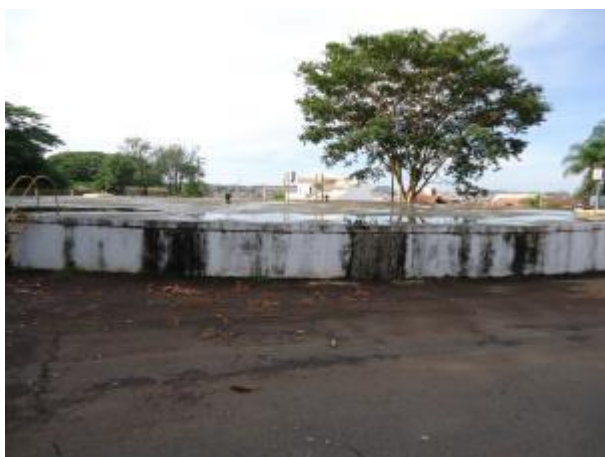
Foto 4.7 – Reservatório de 3.000 m 3 da ETA.
