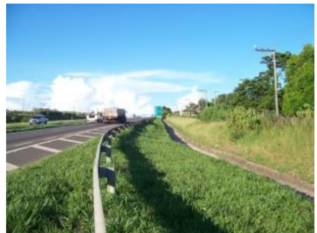
Foto 4.42 - Aspectos da sub-bacia M-D-19. (Fonte: Plano de Drenagem, 2011)
