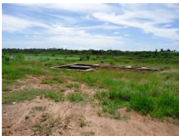
Foto 4.19 – ETE Ipê – Obras paralisadas
