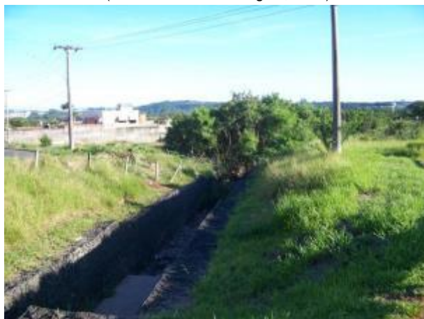
Foto 4.41 - Aspectos da sub-bacia M-D-19. (Fonte: Plano de Drenagem, 2011)
