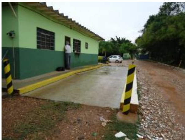
Foto 4.27 – Balança na entrada do aterro sanitário
