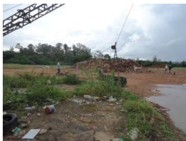
Foto 4.26 – Aterro de Inertes – resíduos de construção civil
