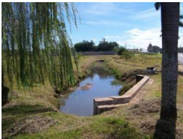
Foto 4.39 - Aspectos da sub-bacia M-D-17. (Fonte: Plano de Drenagem, 2011)
