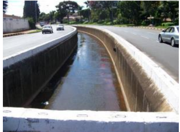
Foto 4.38 - Córrego Cantagalo. (Fonte: Plano de Drenagem, 2011)
