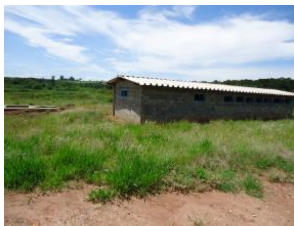
Foto 4.20 – ETE Ipê – prédio construído
