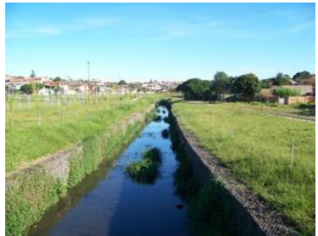
Foto 4.44 - Aspectos da sub-bacia M-E-2. (Fonte: Plano de Drenagem, 2011)
