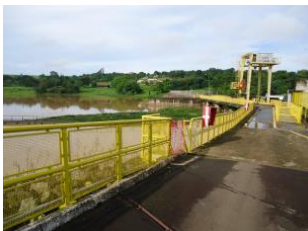
Foto 4.1 – Captação 1 - Detalhe da Barragem no Mogi Guaçu (PCH – AES)
