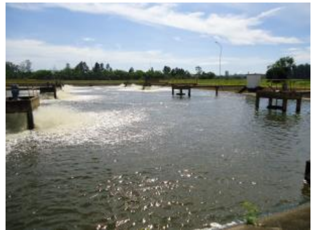
Foto 4.18 – Tanque de aerção da ETE Mogi Guaçu – Av. Brasil.
