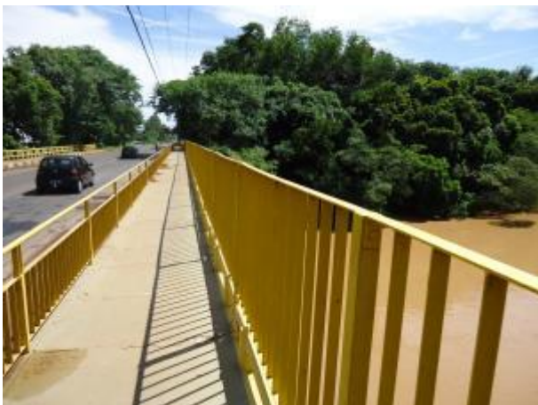
Foto 4.11 – Travessia aérea existente na ponte da Av Brasil.
